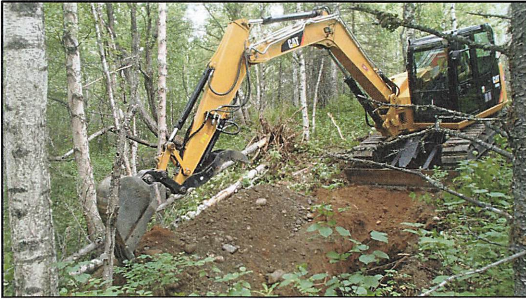
Figure 2. CAT 308E2 CR Mini Excavator
